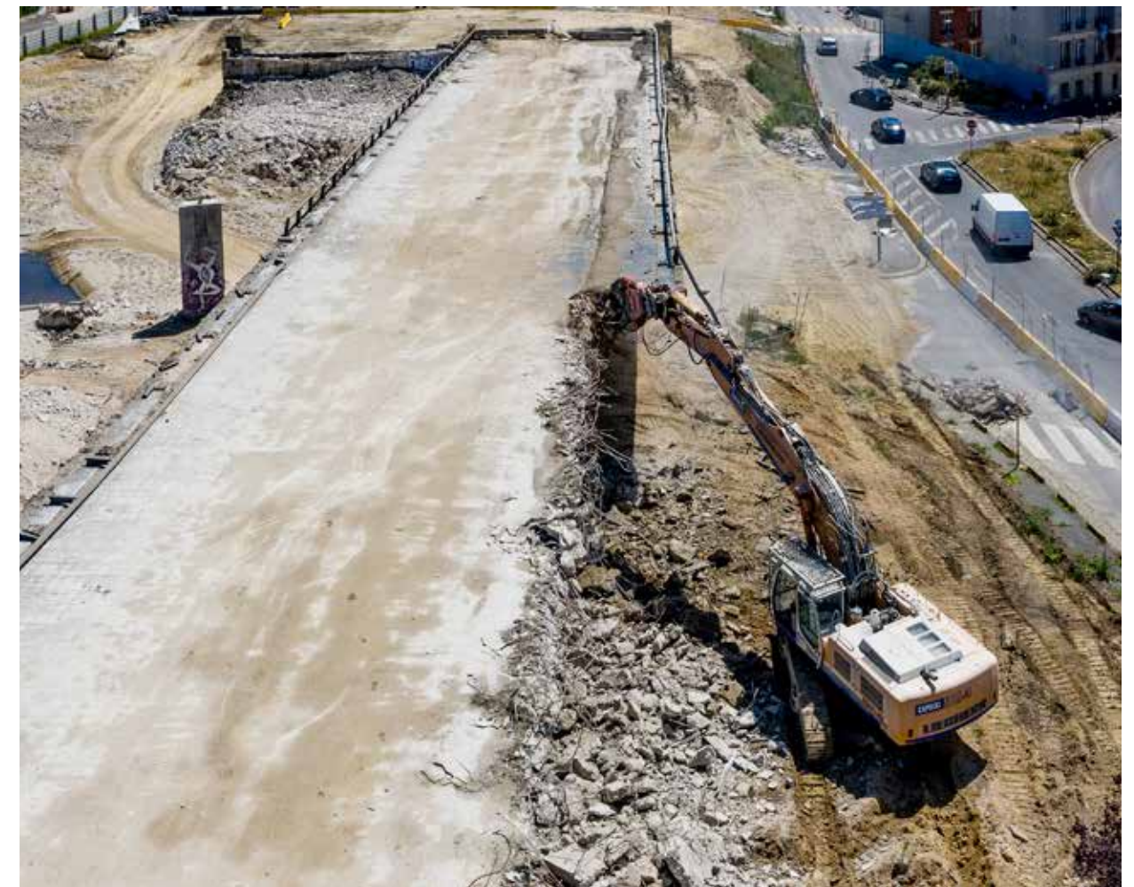
Démolition d'un ouvrage de l'ex-A186
