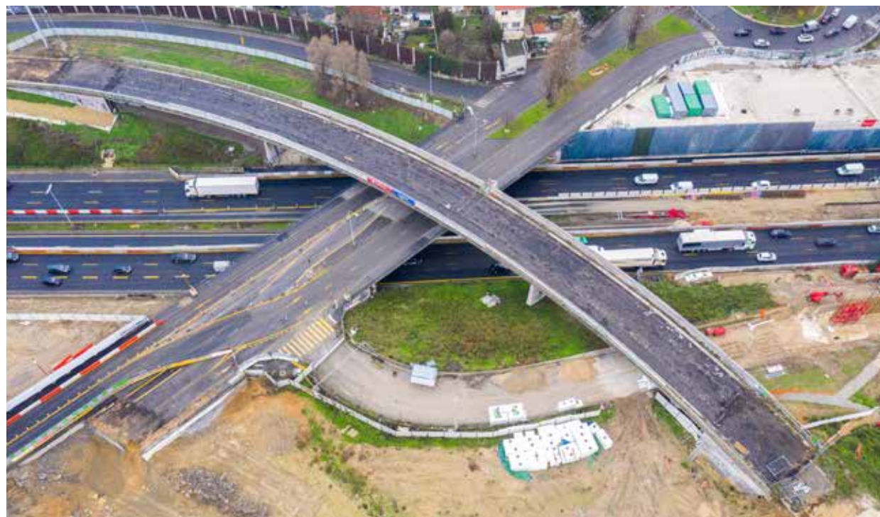
L'ancienne bretelle de l'A186 qui sera démolie en août
